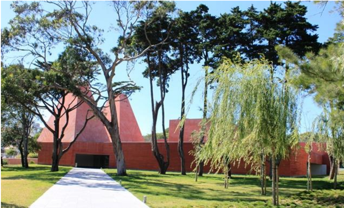
Figura 13 - Vista geral da Casa das Histórias da Paula Rego, ©Gilson Fernandes, 2010
