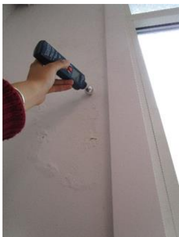
Fig. 5 – Execução de ensaio para obtenção da humidade em profundidade.
