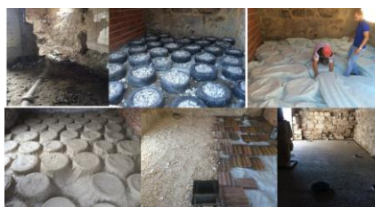
Fig. 2 – Execução do pavimento térreo.
