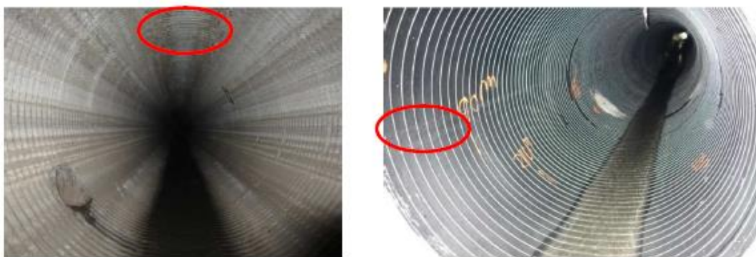
Fig. 5 – Indicação da cota do nível das águas antes (esquerda) e depois da reabilitação com o sistema SPR –PE.
