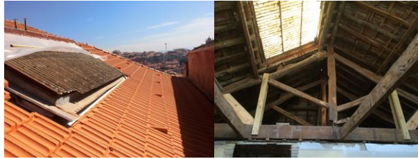
Fig. 4 – Clarabóia existente no edifício.
