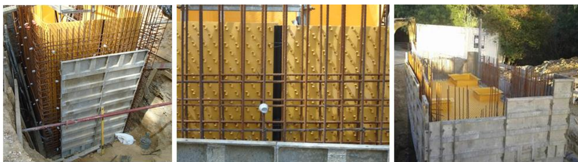
Fig. 4 – Estação Elevatória em Mafra (ALVT) com Sure Grip® HDPE.
