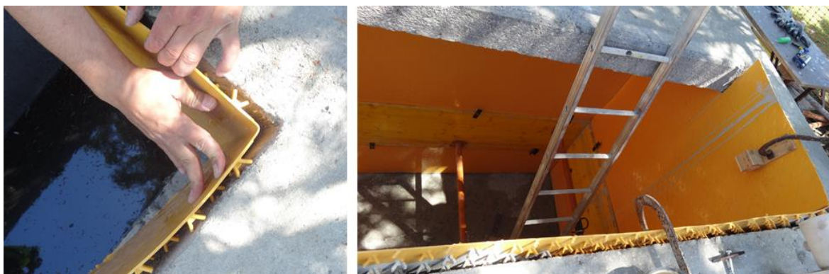
Figura 5 – Reabilitação do Reservatório Equalizador da ETAR de São João da Talha
