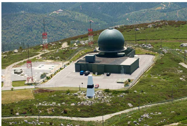
Fig. 3 – Estação Radar nº 1, no Pico da Fóia, Serra de Monchique, a 902 metros de altitude
